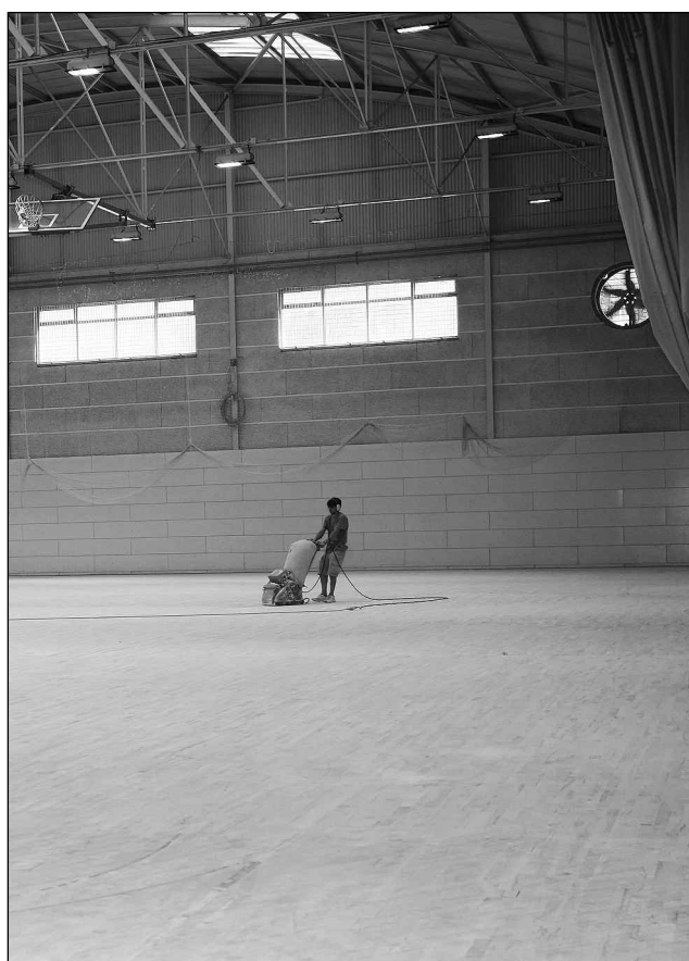
Fent les tasques de millora del parquet de la pista del pavelló
