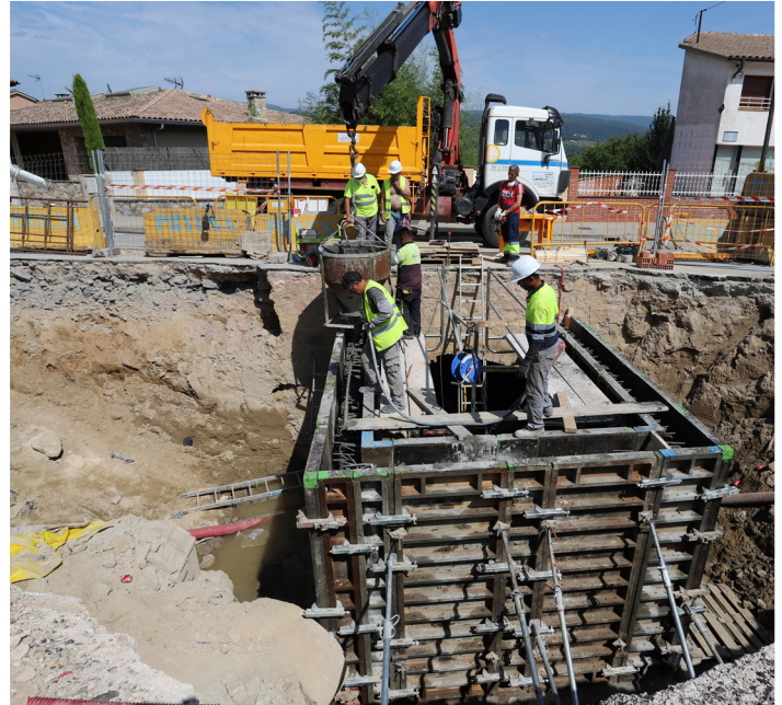
Nova construcció de la canonada d'aigua
