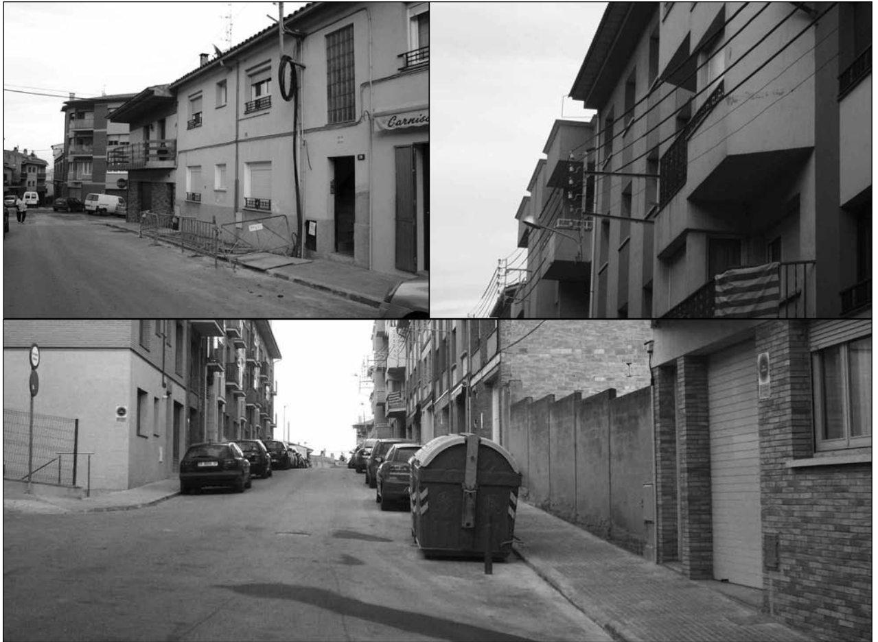
Imatges abans d'acabar les obres del carrer de Vic
