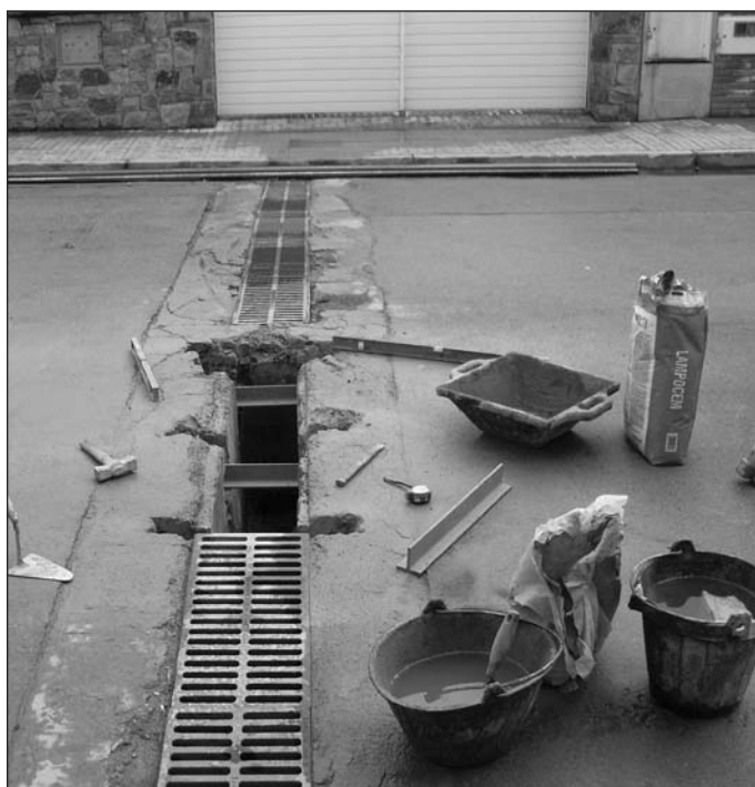
Obres al carrer Girona
