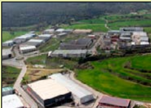
Vista aèria del polígon de la Gavarrà
