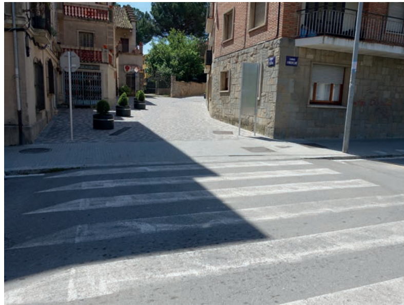
8.2 Construcció de passos de vianants adaptats per a persones amb mobilitat reduïda a les cruïlles dels carrers Marquès de Peñaplata i Josep Anselm Clavé
