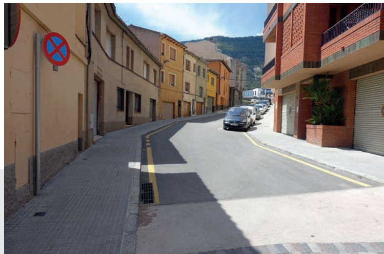
8.6 Ampliació de les voreres del carrer de la Font Calenta
