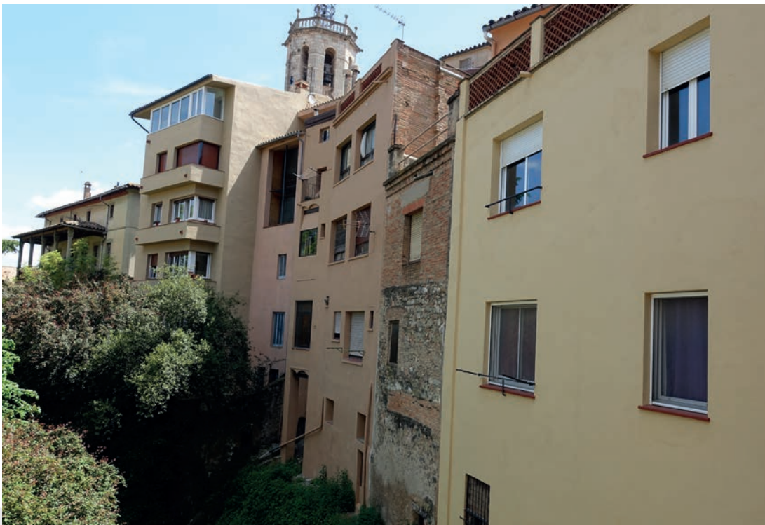
1.5 Rehabilitació de les muralles de la Cira
